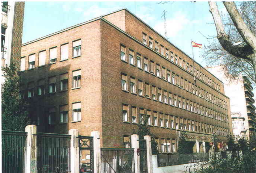
Sede de la Confederación Hidrográfica del Ebro.
