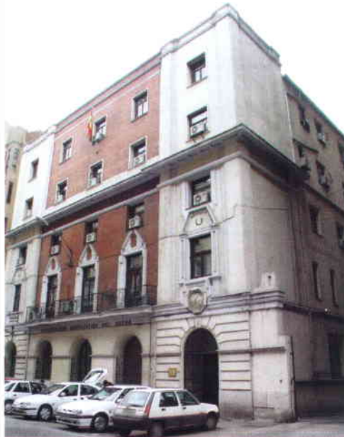
Sede de la Confederación Hidrográfica del Duero.
